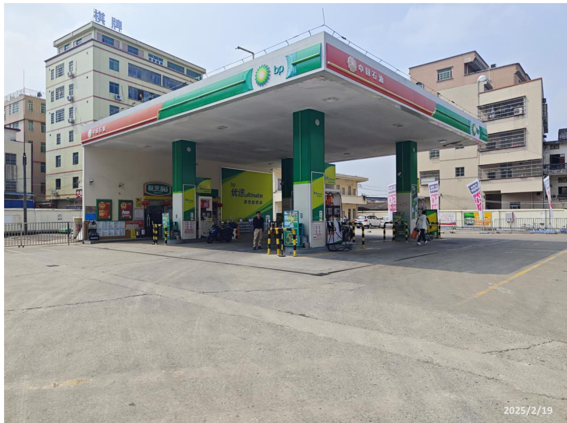
中油碧辟石油有限公司广州观音湖加油站现场照片
