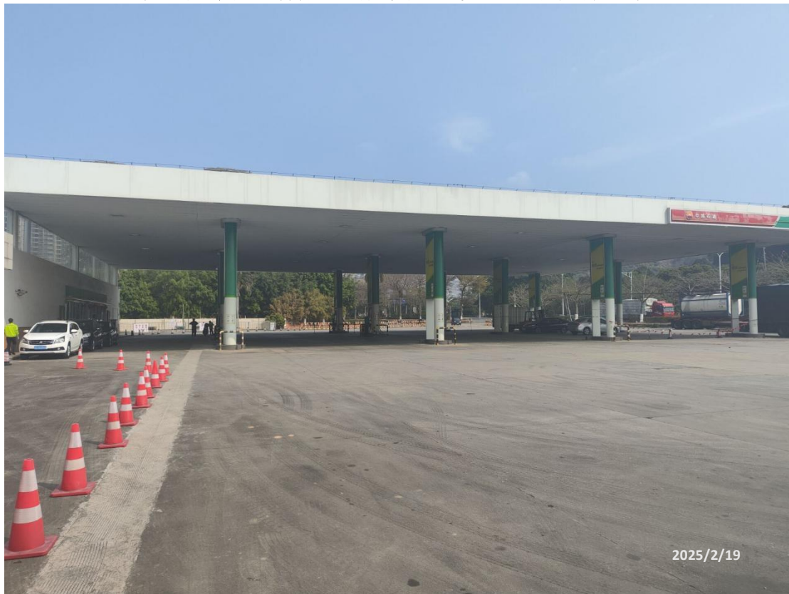
中油碧辟石油有限公司广州九里步加油站现场照片
