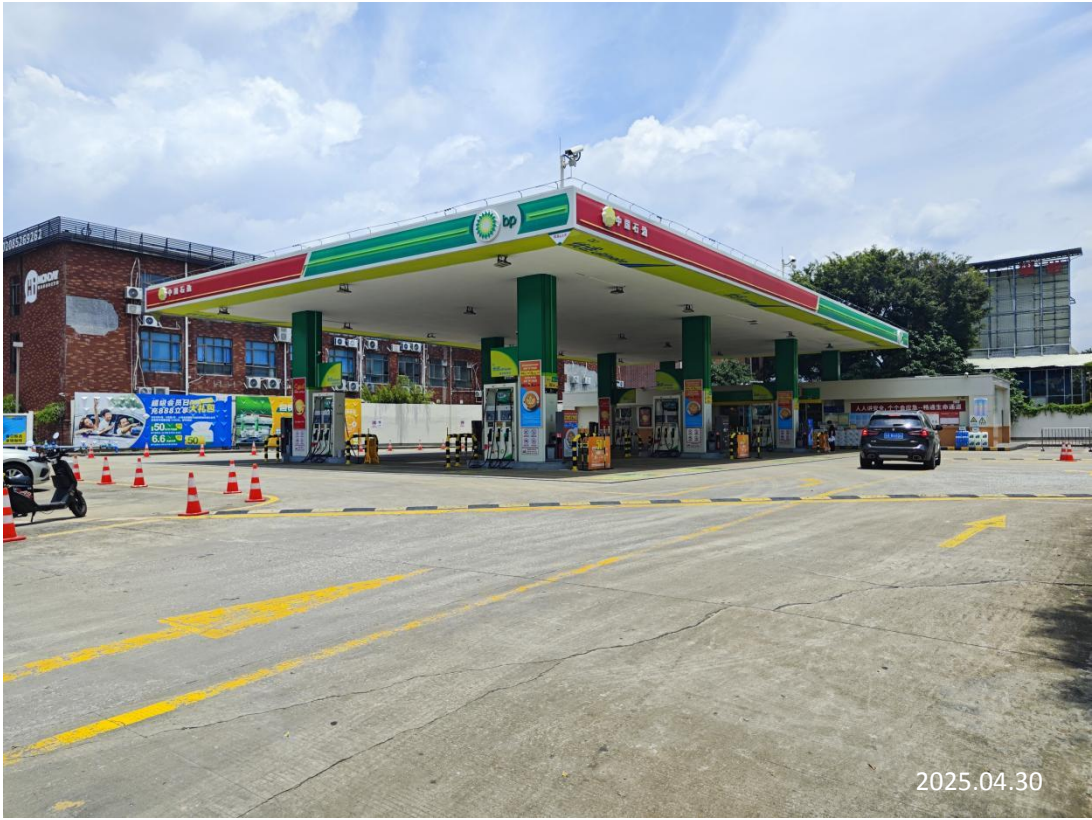
中油碧辟石油有限公司广州敦本加油站现场勘察影像：
