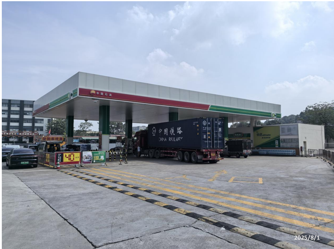
中油碧辟石油有限公司广州骏马加油站现场照片
