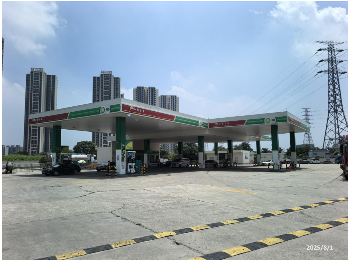
中油碧辟石油有限公司白云万顺达南加油站现场照片
