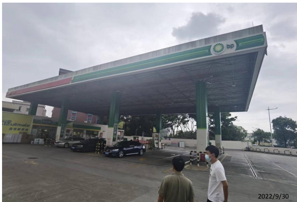
中油碧辟石油有限公司东莞加岭加油站现场勘察照片：
